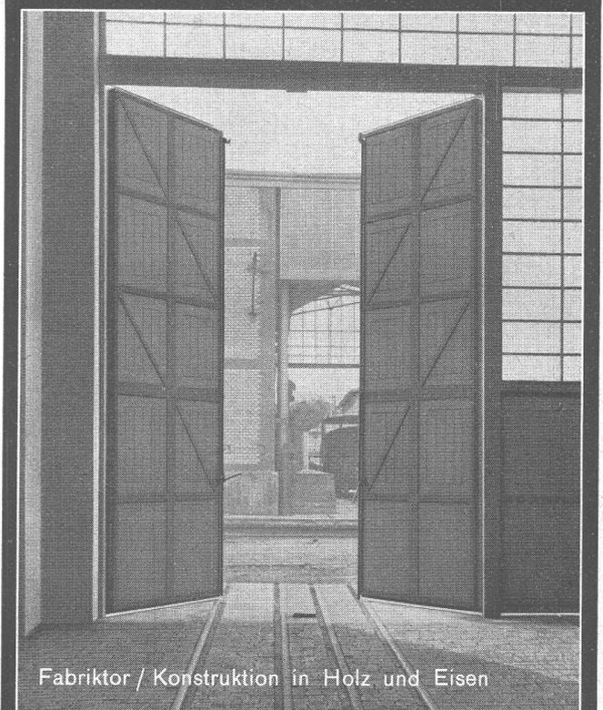
Fabrikator / Konstruktion in Holz und Eisen
