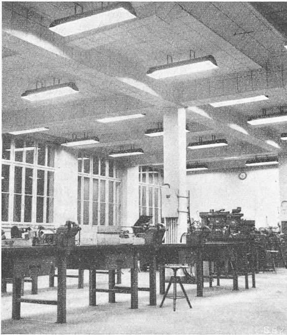
Bild 1. Fabrikbeleuchtung in einer mechanischen Werkstätte mit dreiflämmigen Leuchten für Fluoreszenzlampen TL 40 Watt. Mittlere Beleuchtungsstärke 350 Lux
