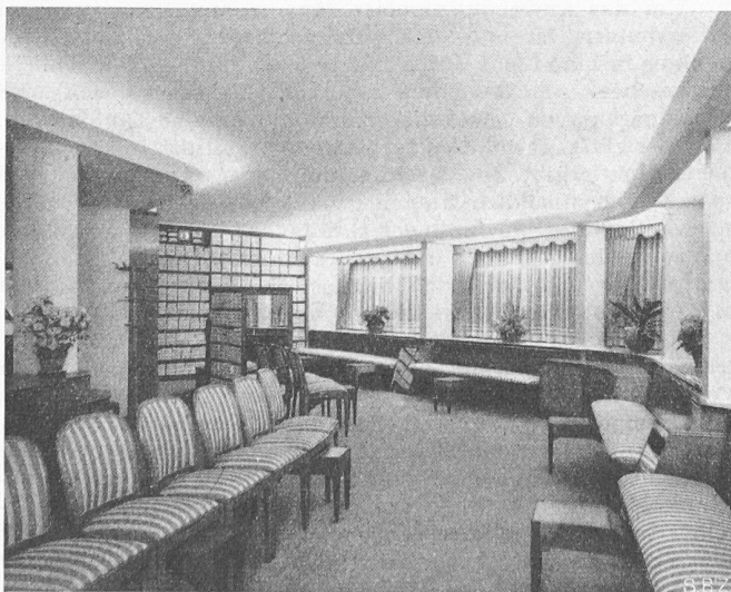
Bild 3. Beleuchtung eines Verkaufslokals mit Fluoreszenzlampen TL 40 Watt. Hauptlicht zwischen den Pfeilern, an den Fenstern und in der Decke, nach unten mit einem mattierten Glas abgeschirmt, zudem in den Hohlkehlen links und rechts des Raumes. Mittlere Beleuchtungsstärke 300 bis 500 Lux
