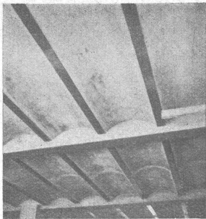
Fabrikdecke ausgeschalt
