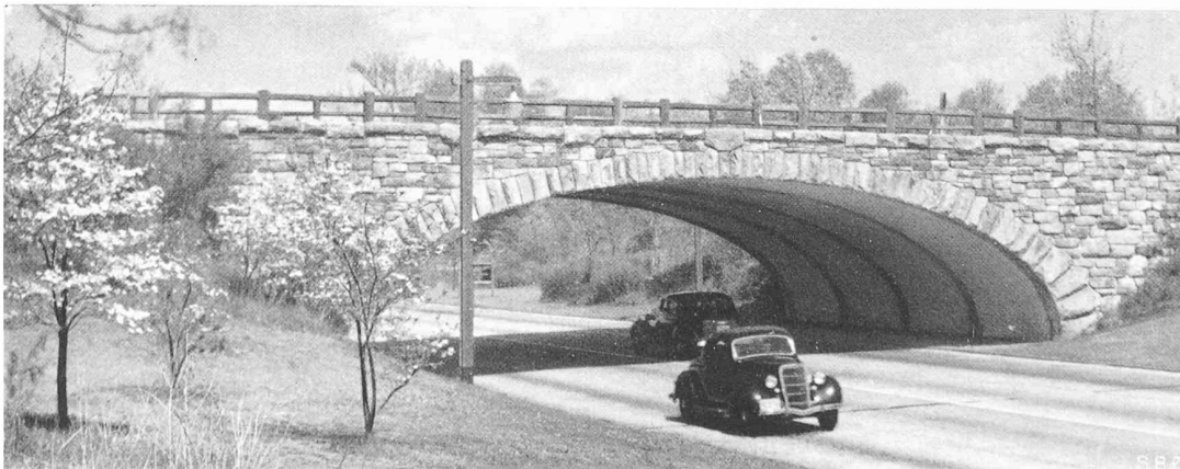
Bild 7. Eisenbeton-Rahmenbrücke mit Steinverkleidung
