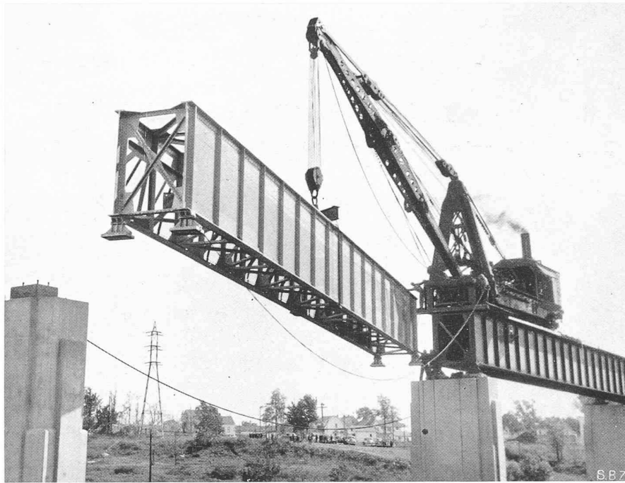
Bild 1. Aufstellung eines 30 m langen Blechbalkens aus Aluminium
