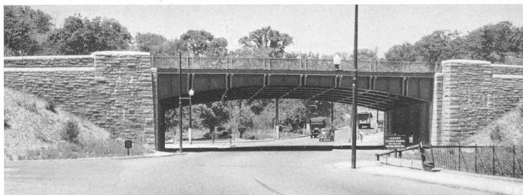
Bild 11. Eiserne Rahmenbrücke mit steinverkleideten Auflagern
