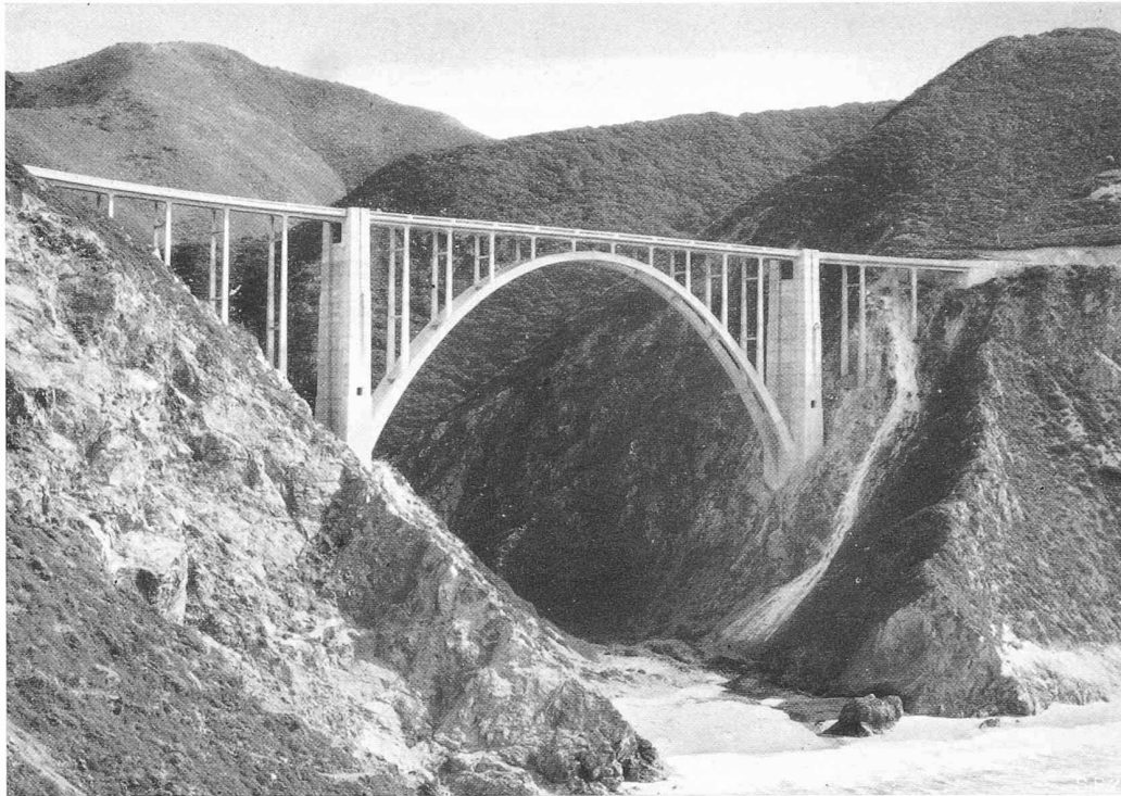
Bild 15. Eisenbeton-Bogenbrücke über den Bixby Creek in Californien
