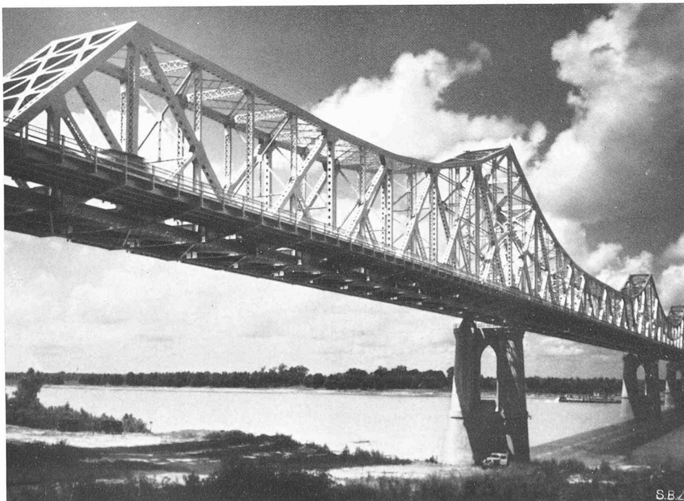
Bild 20. Ausleger-Brücke über den Mississippi bei Baton Rouge
