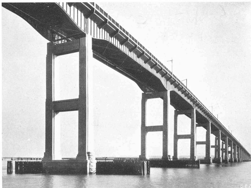
Bild 14. Kontinuierliche Blechträger-Brücke über den Raritan River in New Jersey
