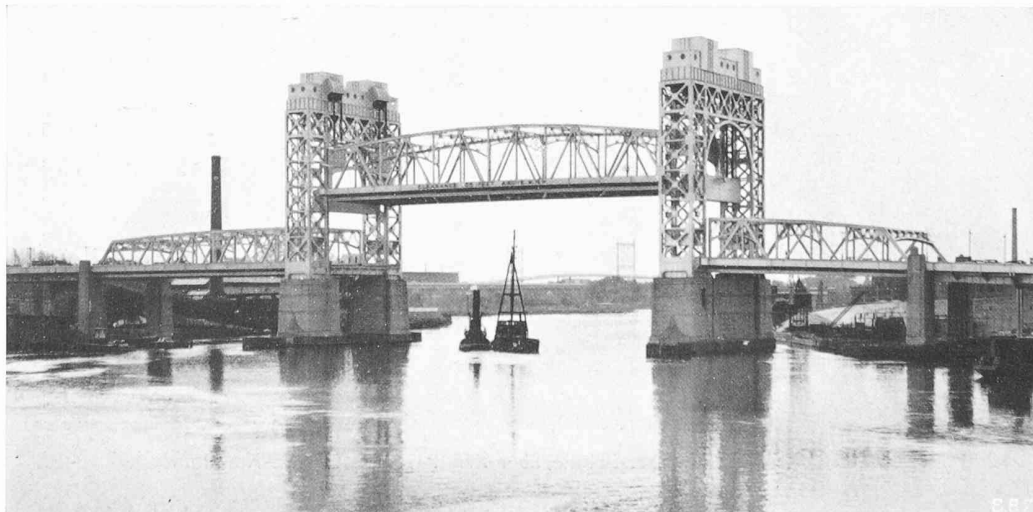
Bild 17. Hubbrücke über den Harlem River in New York (vgl. SBZ Bd. 109, S. 104*)
