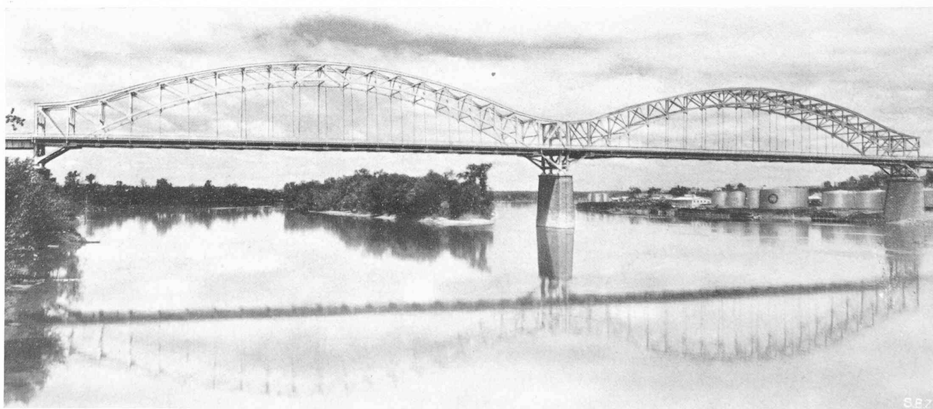
Bild 23. Fachwerkbogen mit Zugband über den Connecticut River bei Middletown
