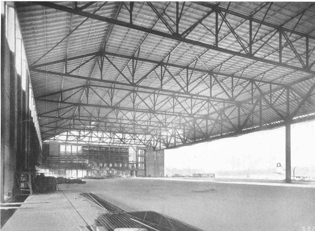
Bild 16. Blick in die Halle von 170 × 62 m Grundfläche. Dacheindeckung teilweise fertig
