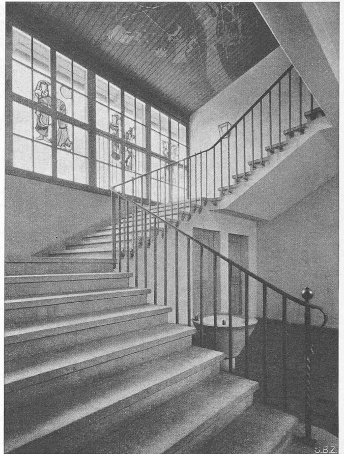
Bild 7. Schulhaus Utogrund, Treppenhaus
