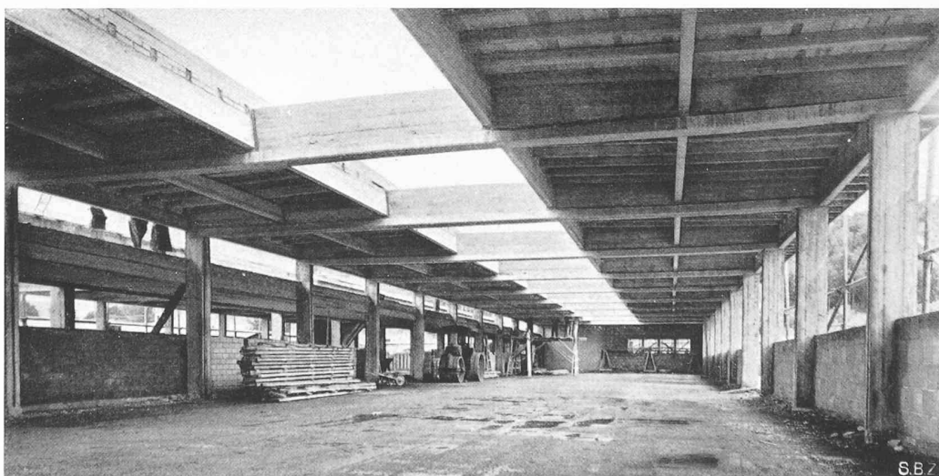
Werkstätten-Halle 14×82 m mit Bindern und Pfetten aus Spannbeton
