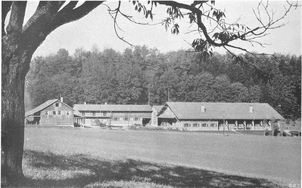
Gesamtansicht aus Süden, links Landwirtwohnung, rechts Rindviehstall und Scheune
