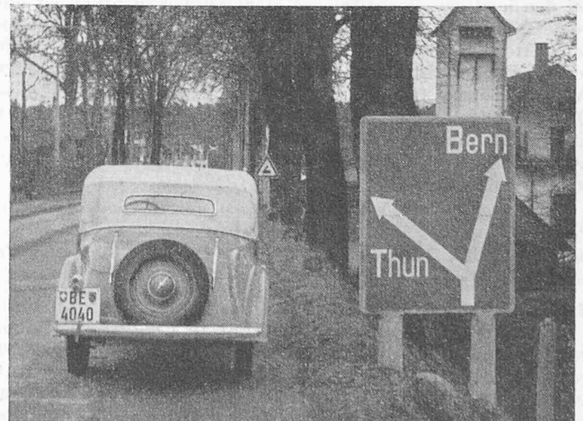
Bild 1. Lava-Vorwegweiser für den Strassenverkehr
