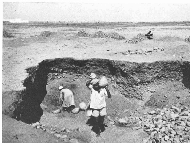
Bild 11. Gewinnung von Betonzuschlagstoffen. Das Material wird in Bastkörben aus der Grube getragen. Im Hintergrund am Horizont die Stadt Jeddah
