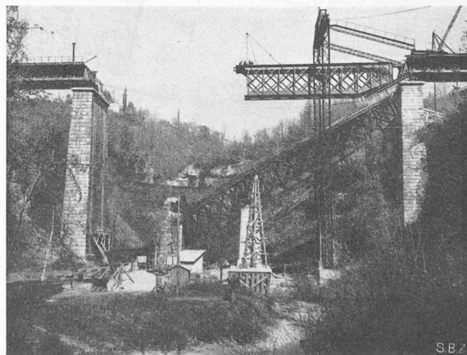
Bild 1. Pymont-Brücke, erste Phase der Wiederherstellung
