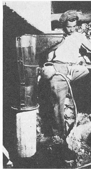
Bilder 16 bis 18. Armierung, Betonieren (Vibrieren) und fertige Pfahlköpfe beim Rihour-Palast
