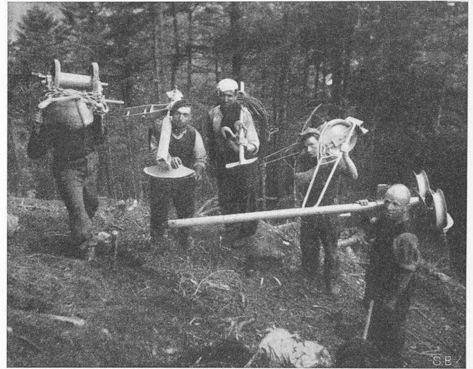
Bild 4. Materialtransport für den Stützenbau im Tessin
