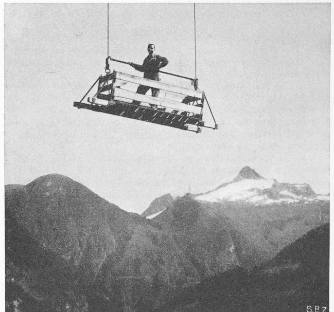
Bild 5. Für Personentransport eingerichtete Kranbrücke, Hubhöhe 60 m
