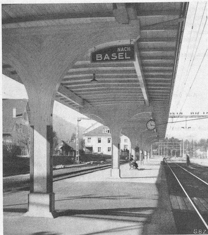
Bild 10. Perrondach in Sissach, Ansicht von unten
