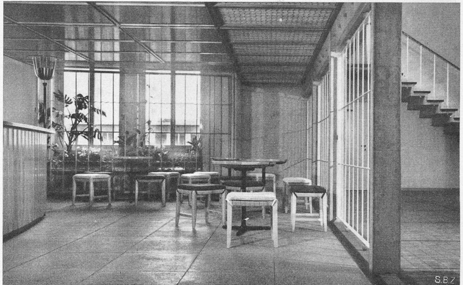
Bild 13. Studenten-Bar im Zwischenbau 3, im 2. Obergeschoss neben der Studentenhalle
