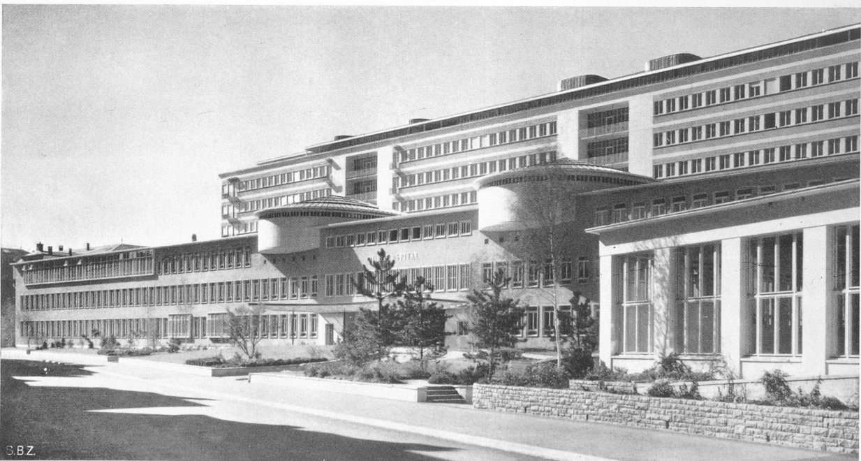
Behandlungsbau aus Norden, dahinter das Bettenhaus, rechts Hauptküche
