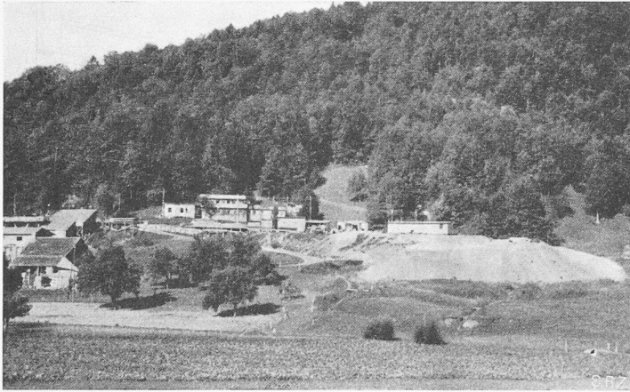
Bild 13. Kohlenbergwerk Riedhof Aegust. Links: Sieb- und Sortieranlage, Mitte: Bureau, Werkstätten, Stolleneingang, anschliessend Deponie
