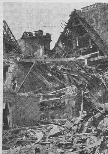
Abb. 4. Links neben dem stehengebliebenen Dachstuhlteil des Ostflügels das viereckige Mitteltürmchen, rechts das Münster
