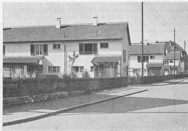
Abb. 4. Blick aus Süden in die mittlere Strasse (Typen A)
