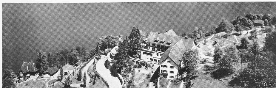
Tiefblick aus Süden
