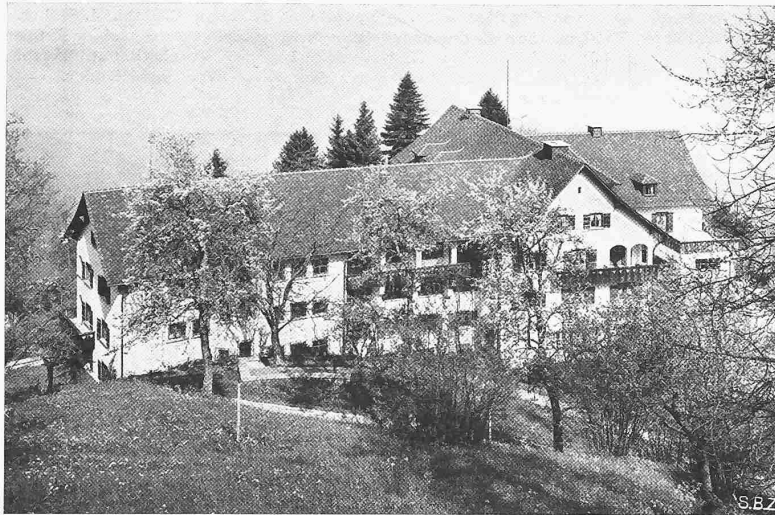
Abb. 3. Bergseite, aus Südosten
