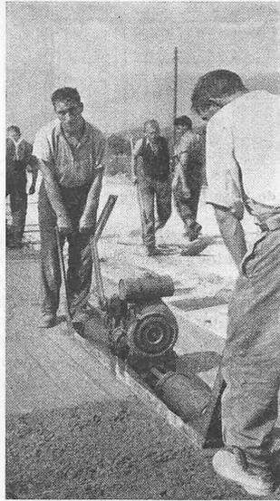
Abb. 12. Vibrationsgerät
