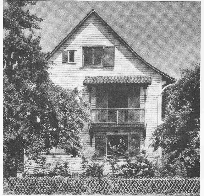
Abb. 3. Südwestseitige Giebelfront gegen die Strasse
