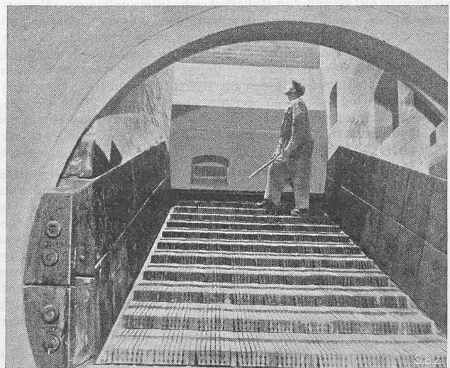
Abb. 7. Der Anzünd-Rost (5 in Abb. 3)
