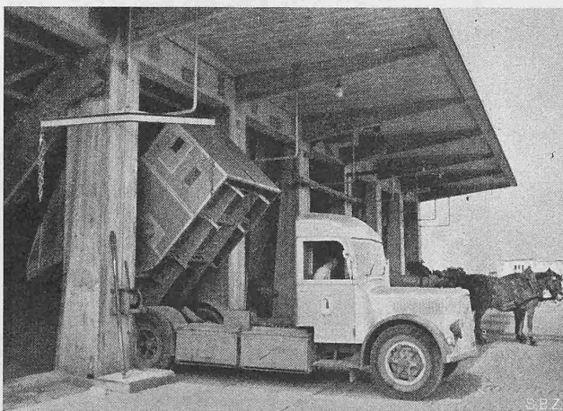
Abb. 4. Entleerung eines Ochsner-Kehrichtsammelwagens in den Tiefbunker
