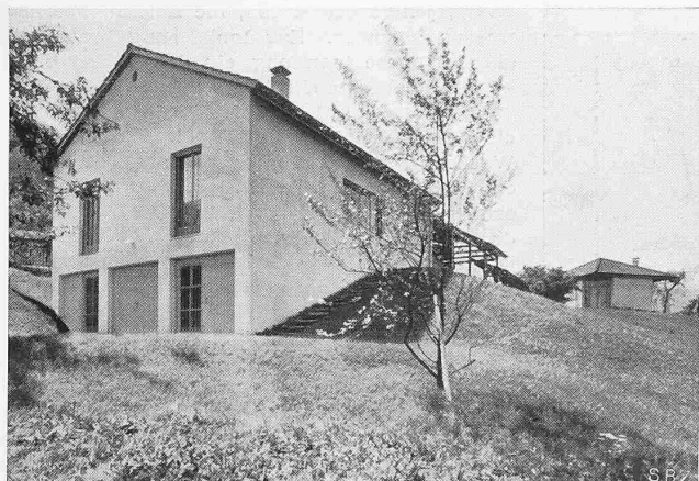
Abb. 6. Garagentore und Waschküche, aus Norden
