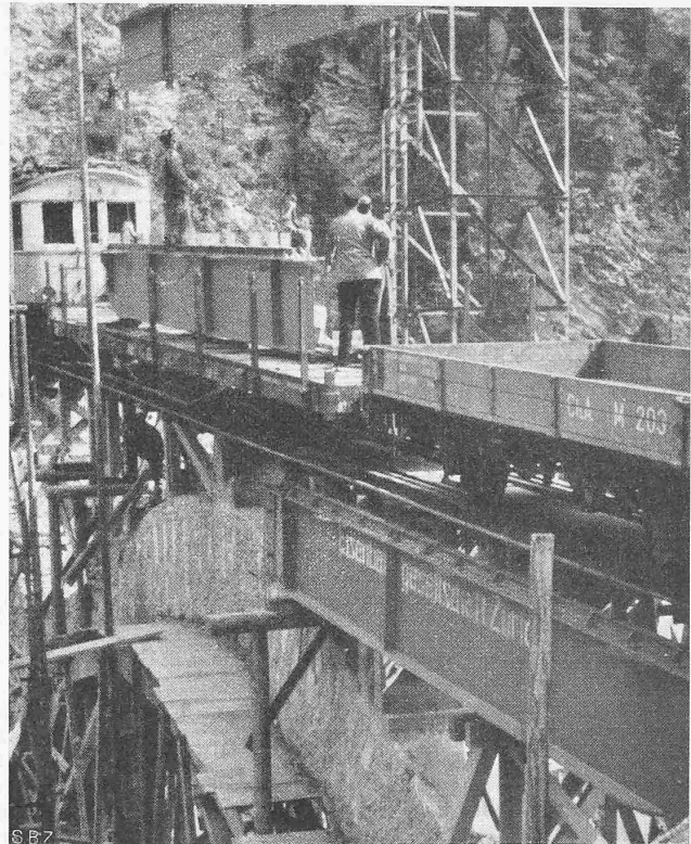
Abb. 39. Einbau der Versteifungsträger in je drei Stücken
