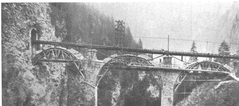
Umbau des Castieler-Viaduktes / Abbruch der Gewölbe und Rekonstruktion der Pfeiler
