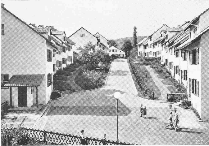
Abb. 4. Hauptstrasse, steigt mit 12% gegen Süden
