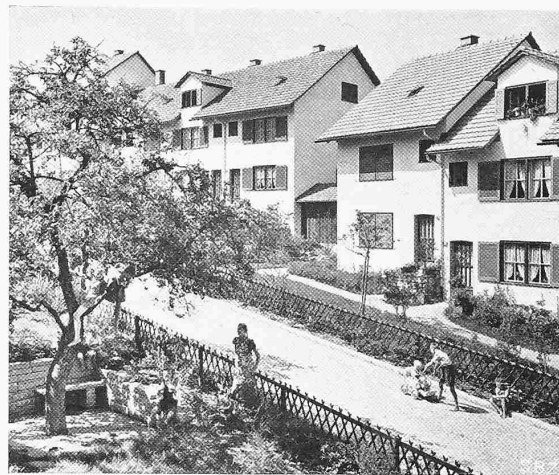
Abb. 10. An der Hauptstrasse, gegen Südwest
