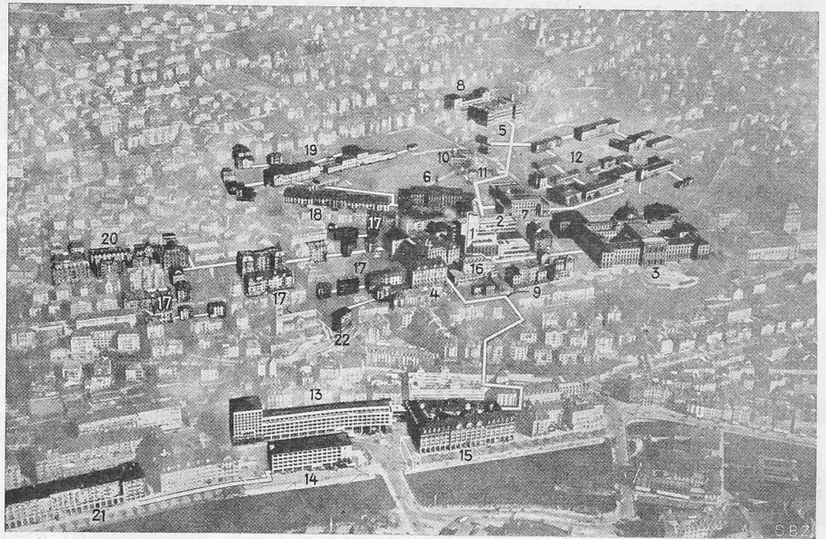
Abb. 1. Uebersicht der vom FHK der E. T. H. versorgten Gebäude (vgl. Bd. 106, S. 141) 1 Fernheizkraftwerk, 15 Kaspar Escher Haus, an dessen linker Ecke das Wärmepump-Ergänzungswerk
