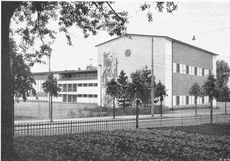
Abb. 3. Ansicht aus Norden, von der Gloriastrasse aus
