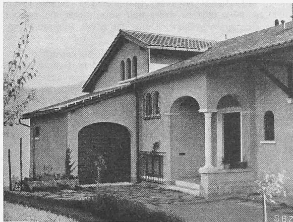
Abb. 3. Haupteingang und Garage an der Nordseite
