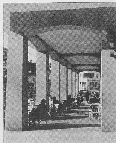
Abb. 6. Arkaden der Südwestseite
