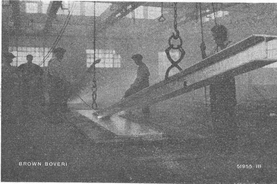
Elektro-Wannenofen für Feuerverzinkung von Röhren und Profilen. Das flüssige Zinkbad hat eine Länge von 8 m und 0,72 m Tiefe; Temperatur 460° C. Anschlusswert 120 kW.
