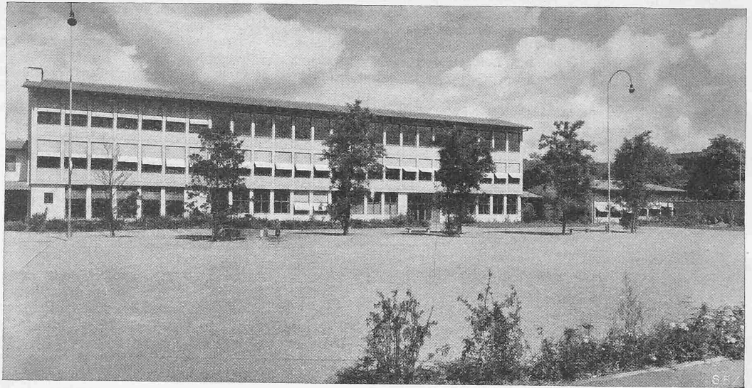
Abb. 19. Turnplatz, hinter der Baumreihe Pausenplatz, Schulgarten und Schulhaus; rechts Tagesheim
