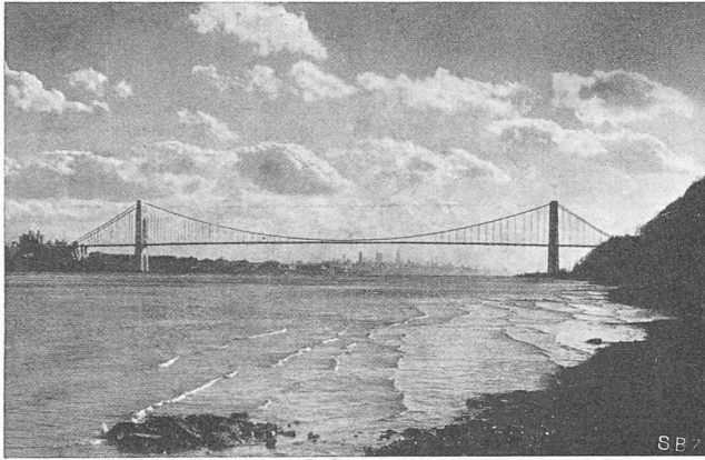
Abb. 4. George Washington-Brücke über den Hudson River in New York
