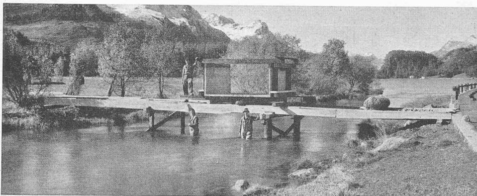
Abb. 10. Provisorisches Stauwehr am Silsersee-Ausfluss, im Bau
