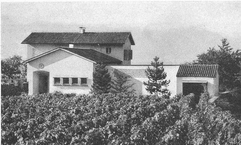
Fig. 2. Vue d'ensemble du coin nord-ouest du terrain
