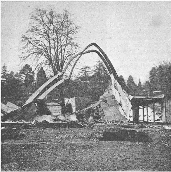
Abb. 10. Ausbildung zweier Knicke mit drei Knickwellen in den auch räumlich ausknickenden Bogenrippen
