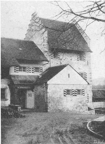
Abb. 3. Ansicht aus Nordost
