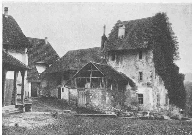
Abb. 1. Ehemaliger Zustand des Schösschens Altenburg
