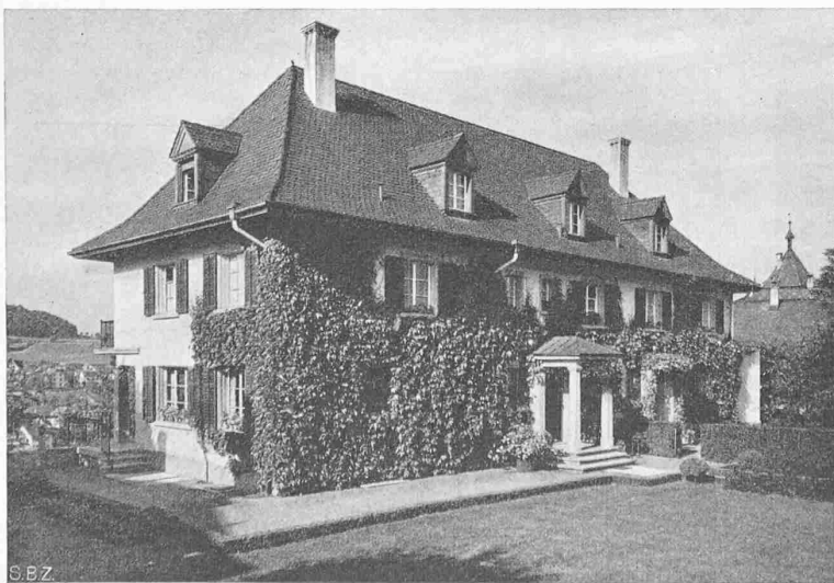
Abb. 6. Rückseite des Doppelwohnhauses Fehr (1929)
