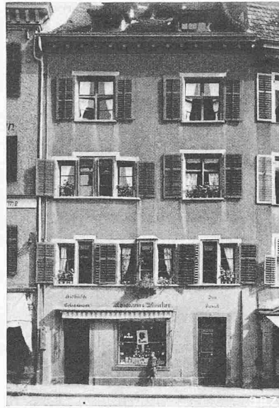
Abb. 5. Altes Haus zum Kessel
