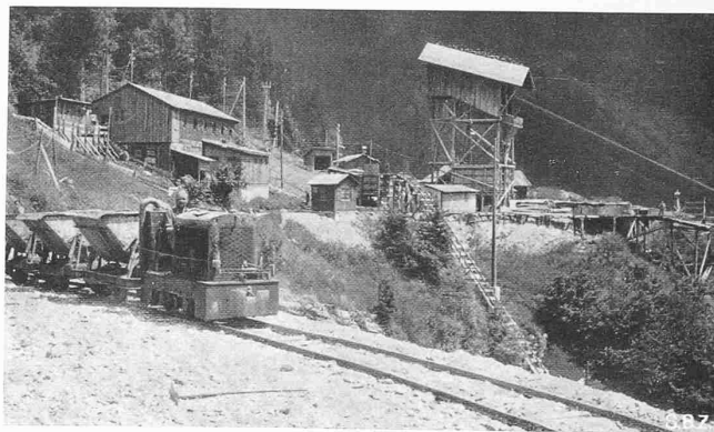
Abb. 6. Obere Endstation der Seilbahn für das Baufenster Hostett
