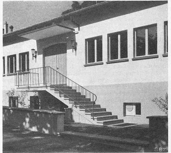
Abb. 3. Aussenzugang zum Saal
