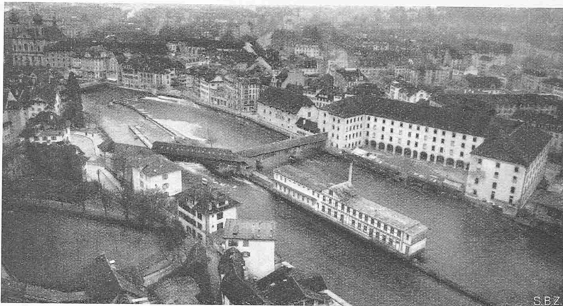
Abb. 2. Spreuerbrücke und alte Kaserne, aus Norden gesehen
