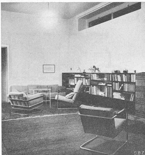
Abb. 10. Wohnhalle, rechts oben Lüftungsschlit
