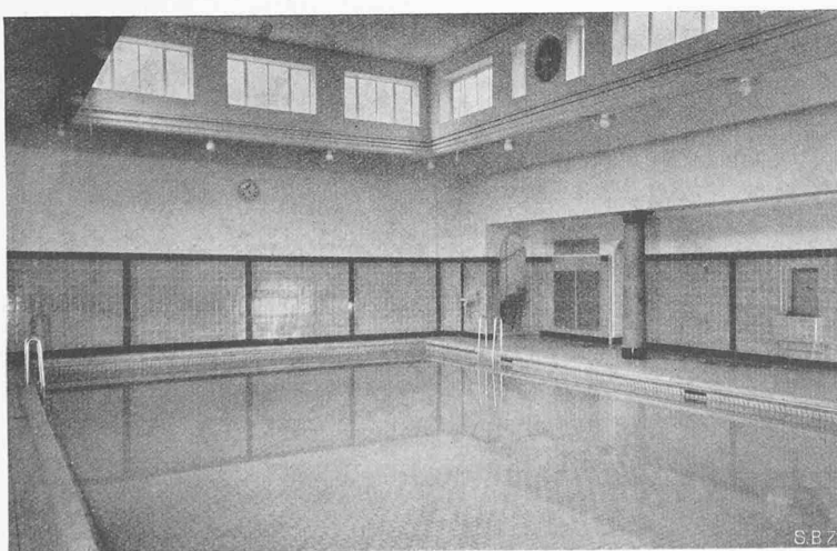
Abb. 13. Alte Halle, zum Nichtschwimmerbad umgebaut
