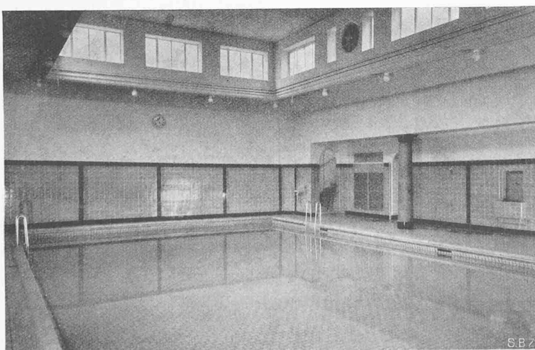
Abb. 13. Alte Halle, zum Nichtschwimmerbad umgebaut
