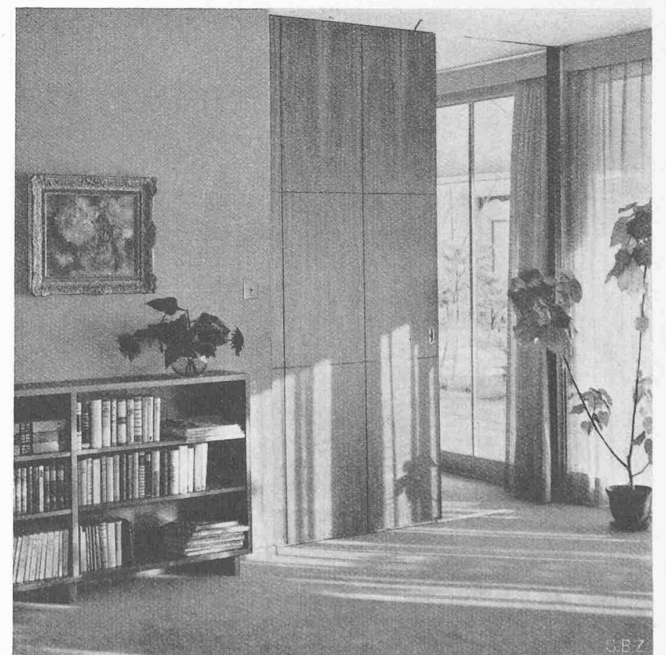
Abb. 8. Schiebetür zum durchgehenden Öffnen der Erdgeschoss-Räume (vgl. Abb. 4)
