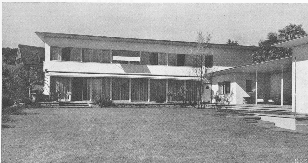
Abb. 2. Vornehmes Wohnhaus am Zürichberg. Arch. A. H. STEINER, Zürich (Text siehe Seite 70)
