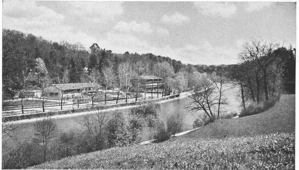
Abb. 3. Blick flussaufwärts auf Tierkindergarten, Oekonomiegebäude und Restaurant
