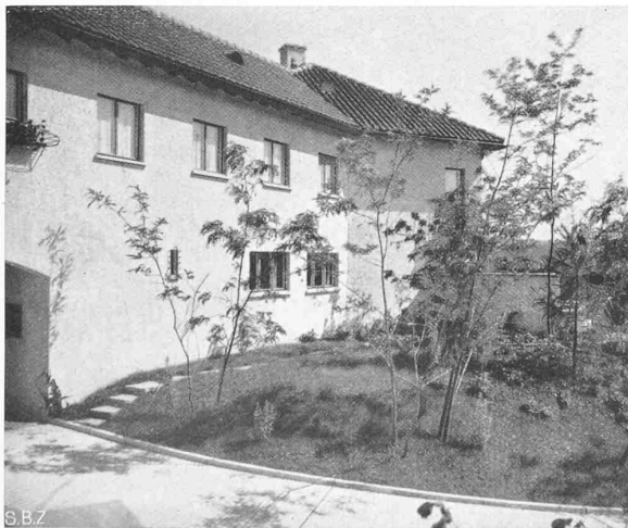
Abb. 5. Westflügel, links die Hofeinfahrt
