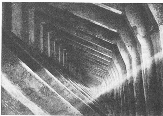
Ufermauer am Quai Turretini in Genf Entwurf von Ing. R. MAILLART † Abb. 3 (links). Schalung der Rahmen Abb. 4 (oben). Innenbild der Hohlkonstruktion
