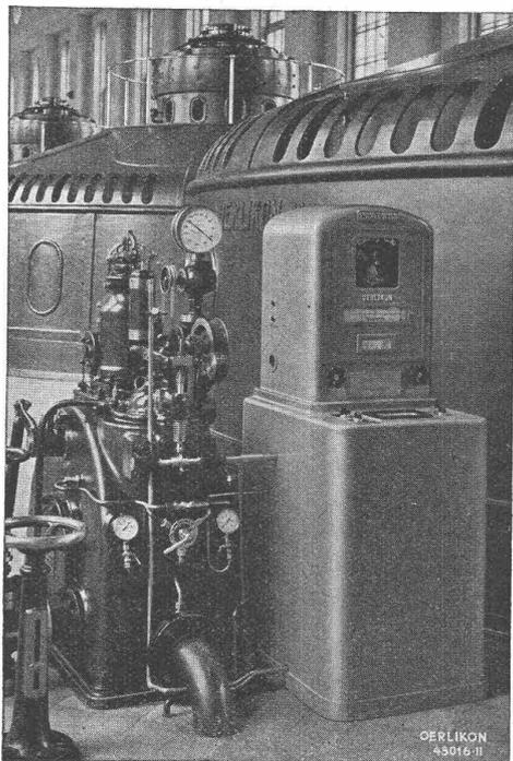
Drehzahlregler System Escher Wyss-Oerlikon (rechts)
