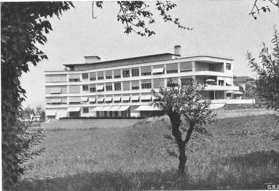
Abb. 1. Erweiterungsflügel des Bürgerspitals Zug, aus Süden gesehen
